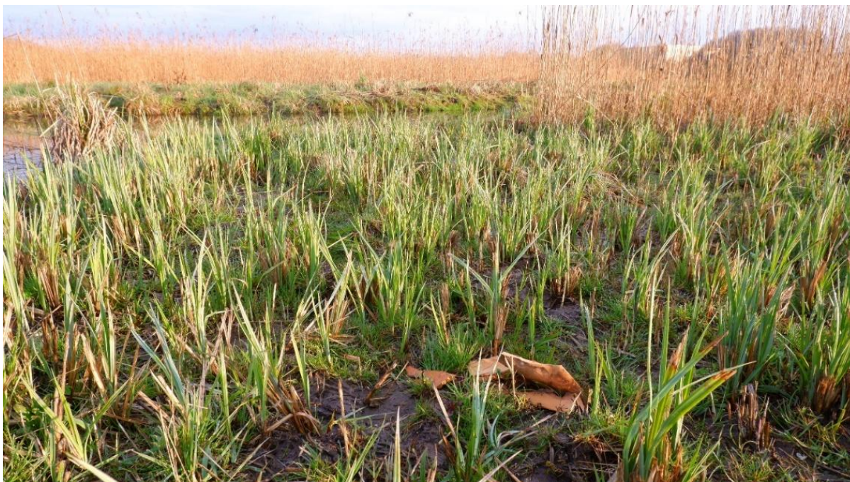
Obr. 38: Vegetace vysokých ostřic a rozpadlá drenážní trubka.
