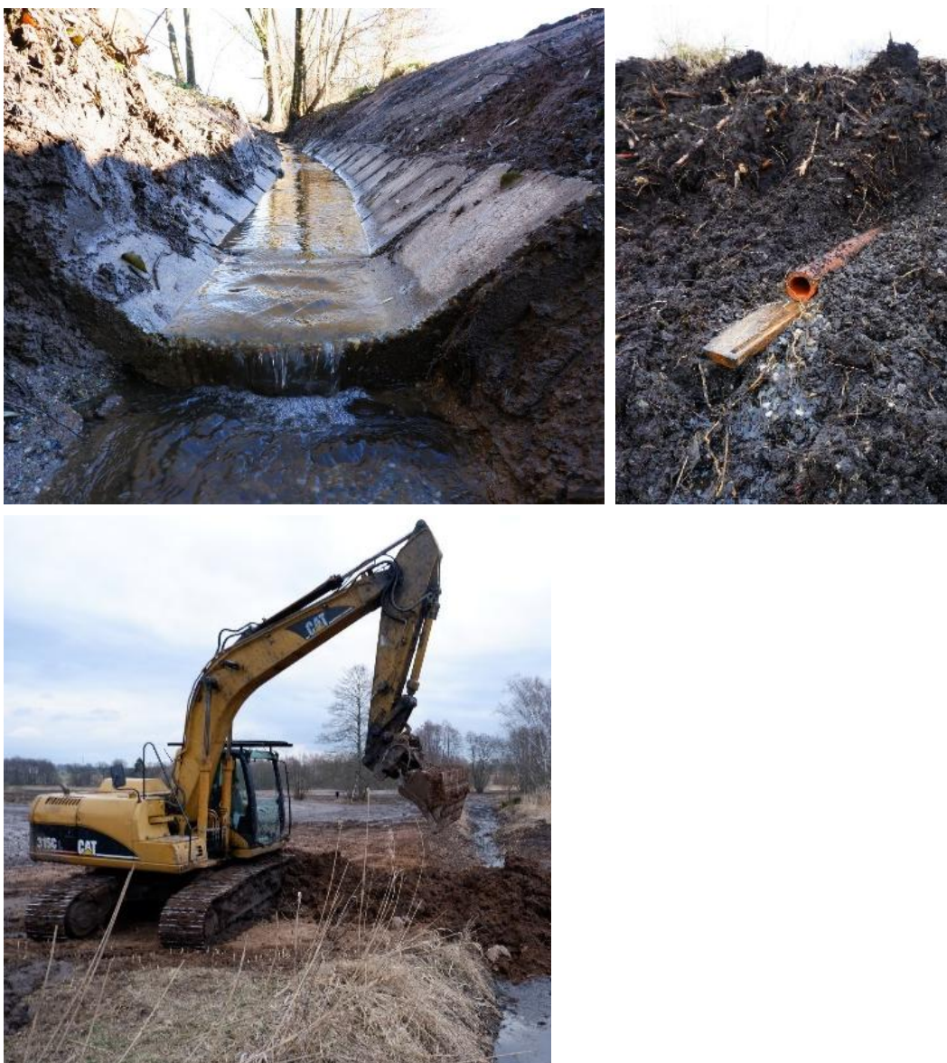
Obr. 17 – 19: Během projektu revitalizace západní části území byly kompletně meliorace v této části znefunkčnĚny.
