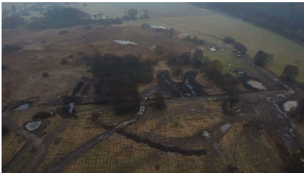
Obr. 45: Foto z dronu z průběhu realizace revitalizace území.
