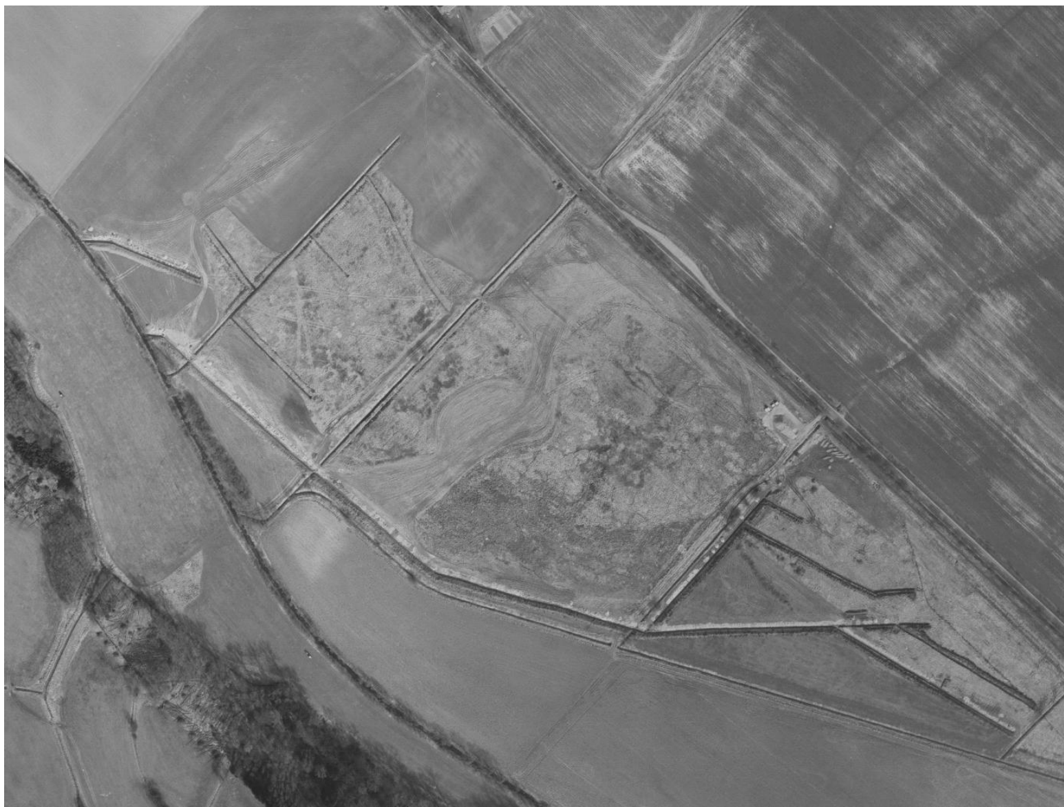
Obr. 92: Letecký snímek z roku 1990. Pročištění stávajících HOZ a vytvoření nové sítě plastové drenáže. Plocha postupně ještě více zarůstá.
