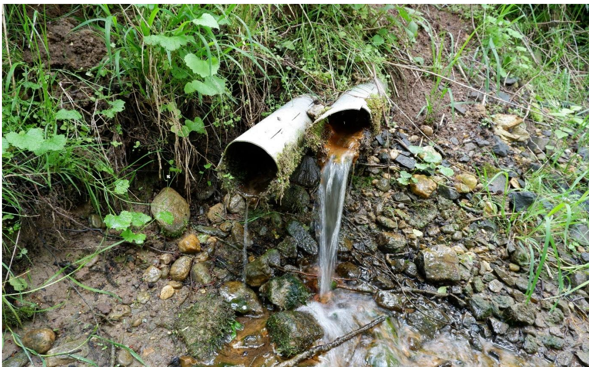
Obr. 26: Stále funkční odtok plastovou drenáží z 90. let 20. století z polí a luk pod Novou Vsí západně od mokřadů.
